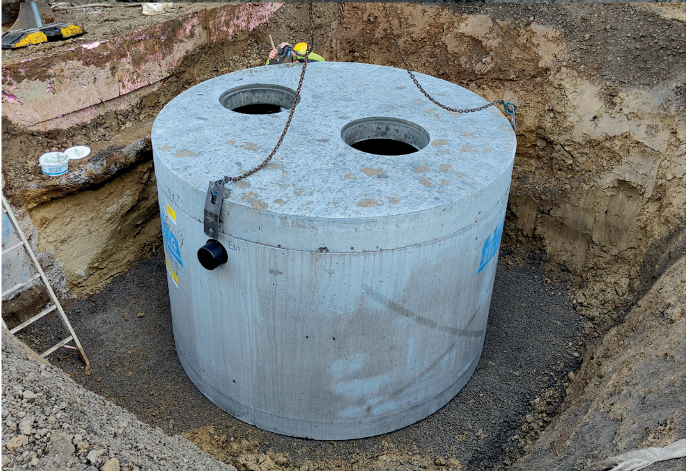
friwa Kompaktanlage (Schlammfang und Mineralölabscheider)
